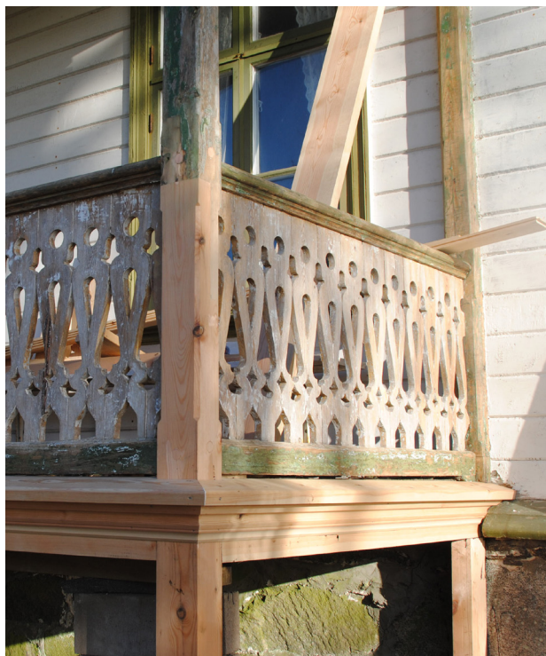
Högra sidan av verandan. Den yttre stolpen har lagats i nedtill. Nytt listverk har monterats och under verandagolv har stolpar mot marken bytts.
