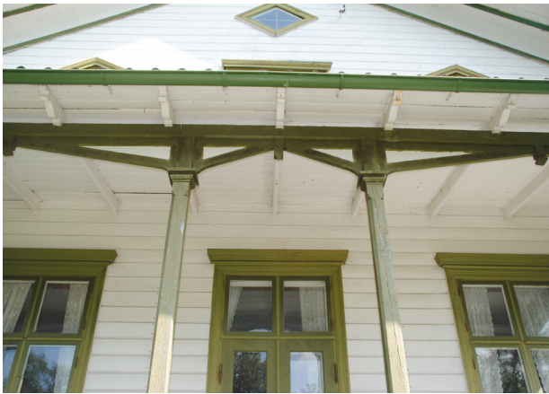
I framkanten på verandataket syntes skador. Det fanns läckage i taket.
