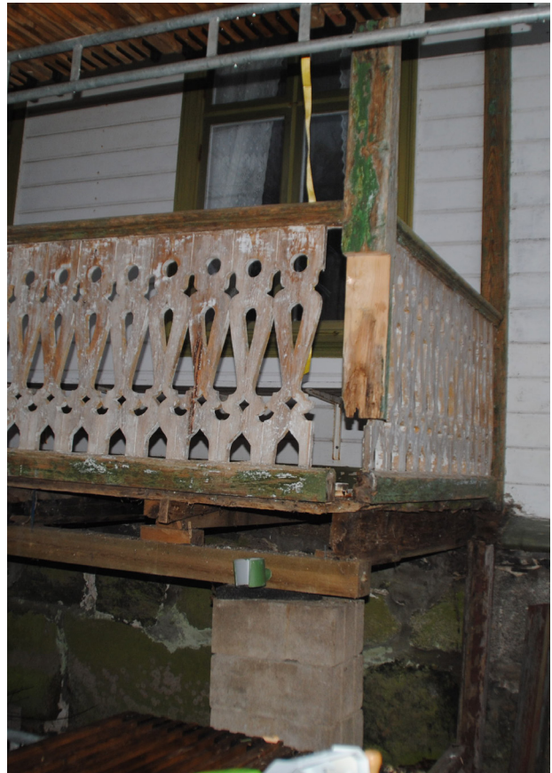
Den högra stolpen håller på att renoveras. Den kapades en bit upp för att kunna skarvas i halft i halft med en ny nedre del.
