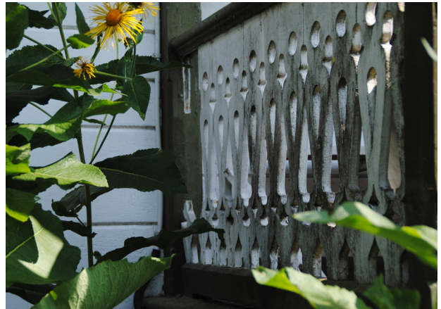
Den inre figursågade spjälan i räcket saknades.
