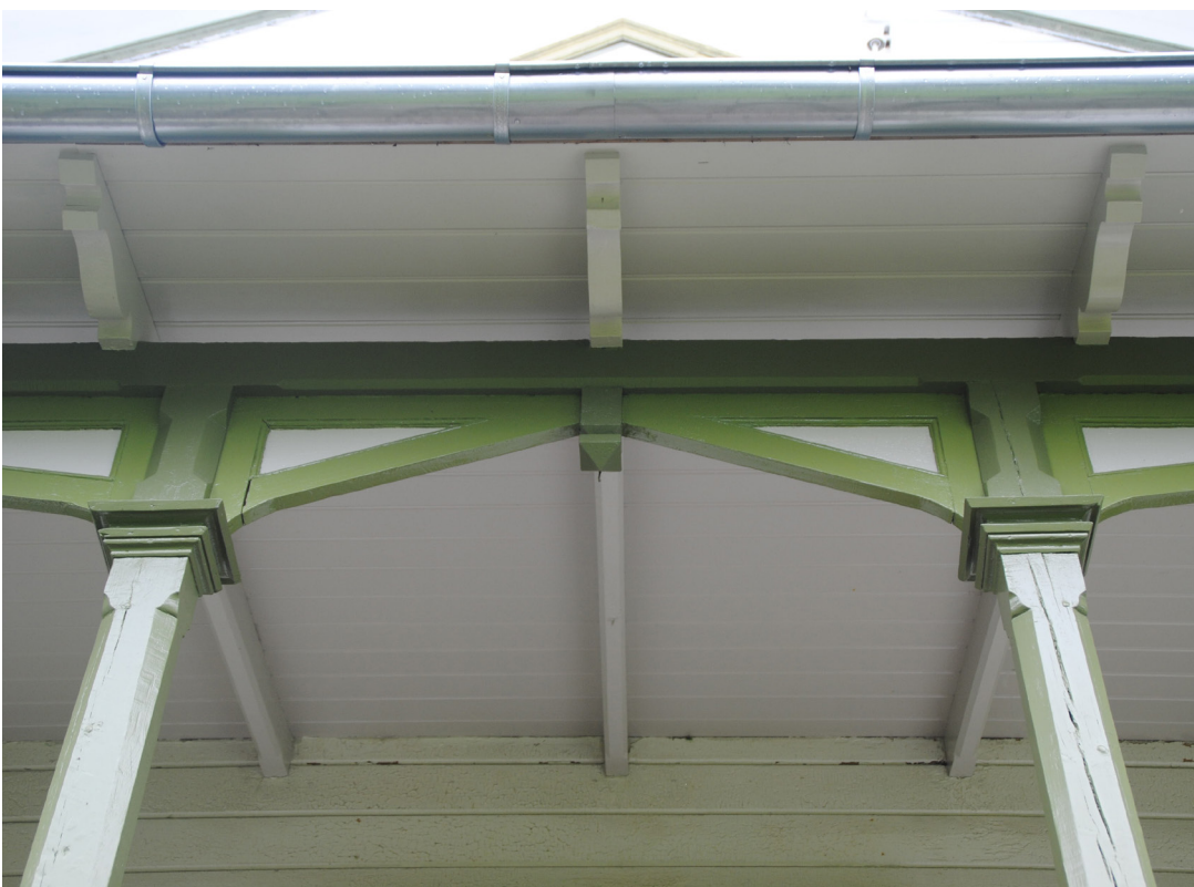
Verandataket har bytts ut. Verandan har målats i fyra kulörer, två gröna, en bruten vit och en ljus grå.
