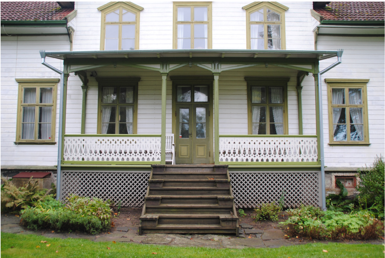
Verandan efter renovering.
