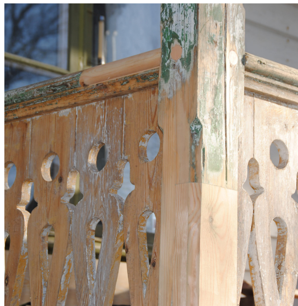
De yttre stolparna har lagats i halv i halvt. Lagningen är så väl utförd att den knappt syns.
