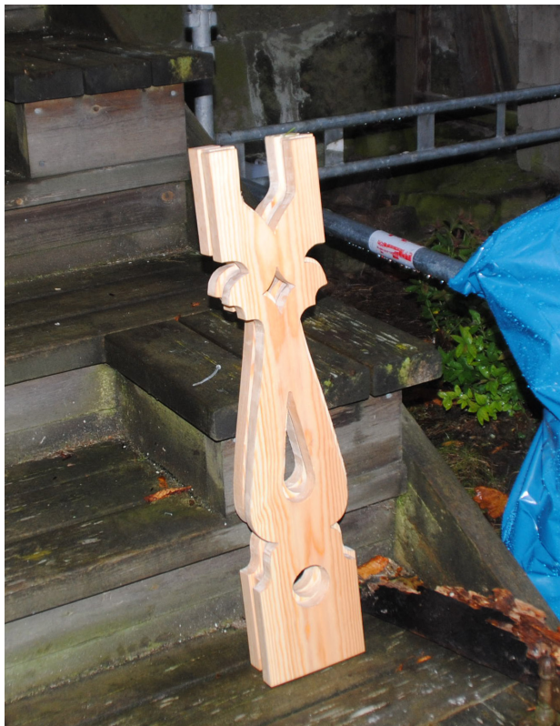
Nyttillverkade figursågade spjälor för ilagning där det saknades eller fanns skadade spjälor.
