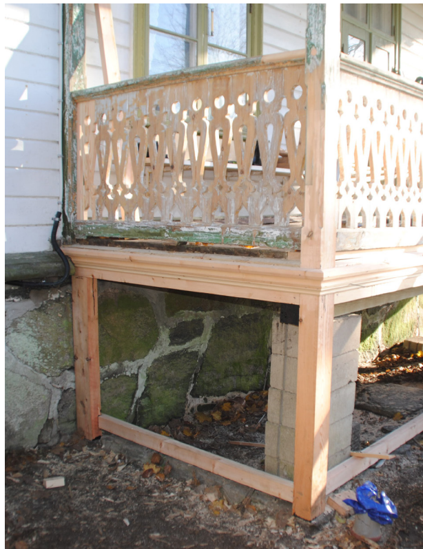
Verandans vänstra gavel. Ny spjälå har monterats innerst på räcket. Den yttre stolpen har lagats i nedtill och nytt listverk i höjd med verandagolvet har monterats. Under verandagolv har den yttre stolpen samt regler för montering av spjälverket bytts ut.
