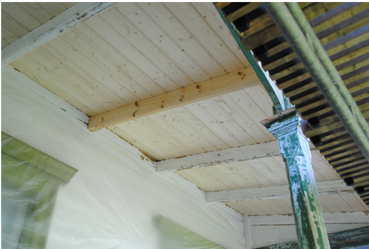
En av bjälkarna i taket var så rötskadad att den har fått bytas helt. När plåttak och papp revs visade sig att pärlspontpanelen i taket hade större rötskador än vad som var synligt underifrån och därför togs beslut att riva hela det befintliga taket och ersätta det med nytt med samma mått som det gamla.
